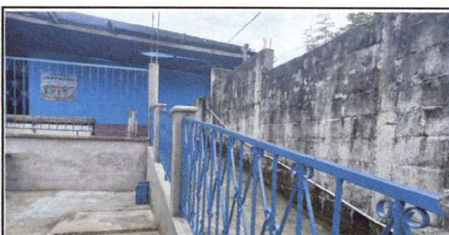
Foto 6: cernido, repello y sellado de grietas en muro, trabajo terminado.
