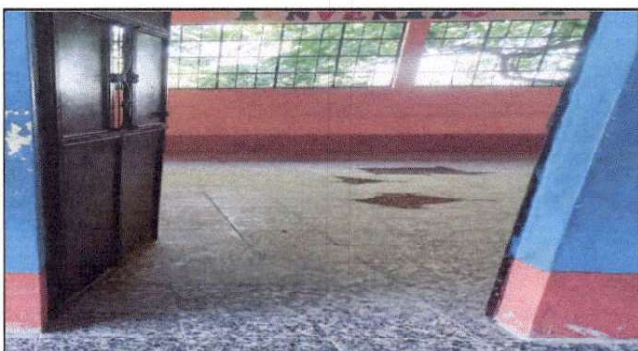
Foto 3: aula con sustitución de piso de granito nuevo en Módulo I
