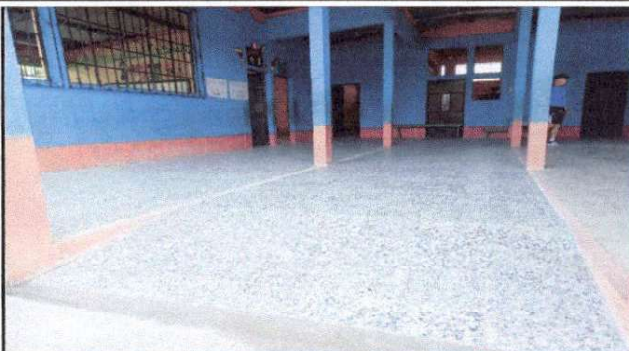
Foto 2: corredor con piso de granito nuevo, trabajo terminado.
