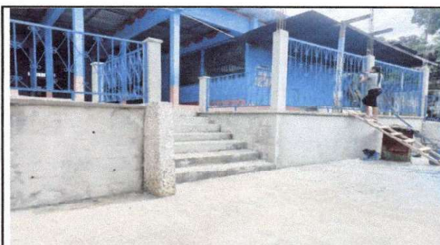
Foto 4: cernido, repello y sellado de grietas en muro trabajo terminado.
