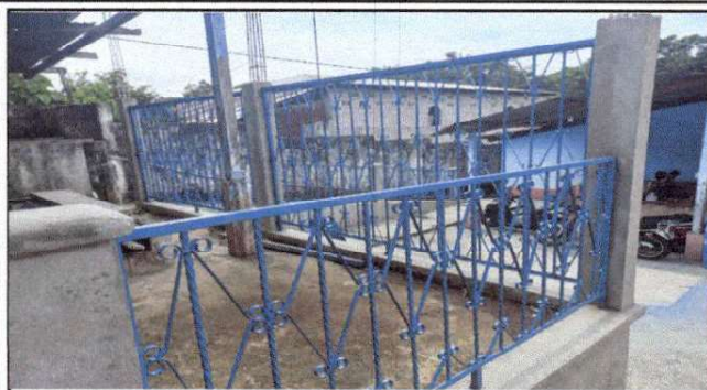
Foto 7: colocación de balcones de metal después del mantenimiento respectivo, trabajo terminado.
