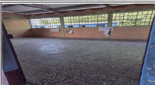
Foto1: Aula con sustitución de piso de granito en Módulo I.
