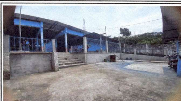
Foto 8: vista panorámica de la colocación de balcones, trabajo terminado.
